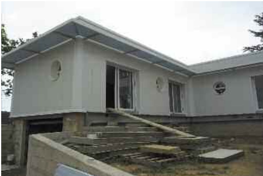
Construction d'une maison individuelle contemporaine à Saint-Jean-Pia-de-Corts (Pyrénées-Orientales) Altitude : 140 m
