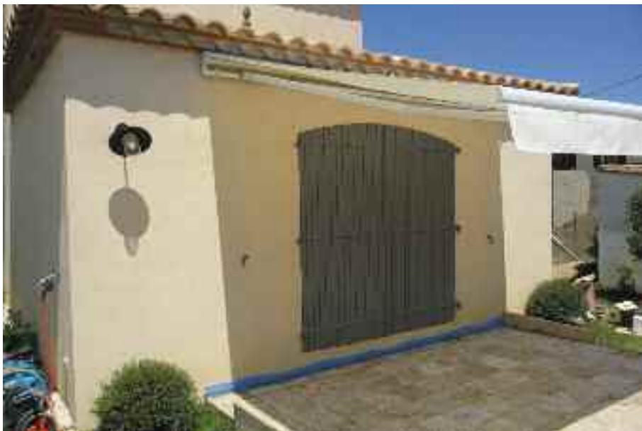
Construction d'une bastide individuelle de type 5 à Narbonne (Aude)
