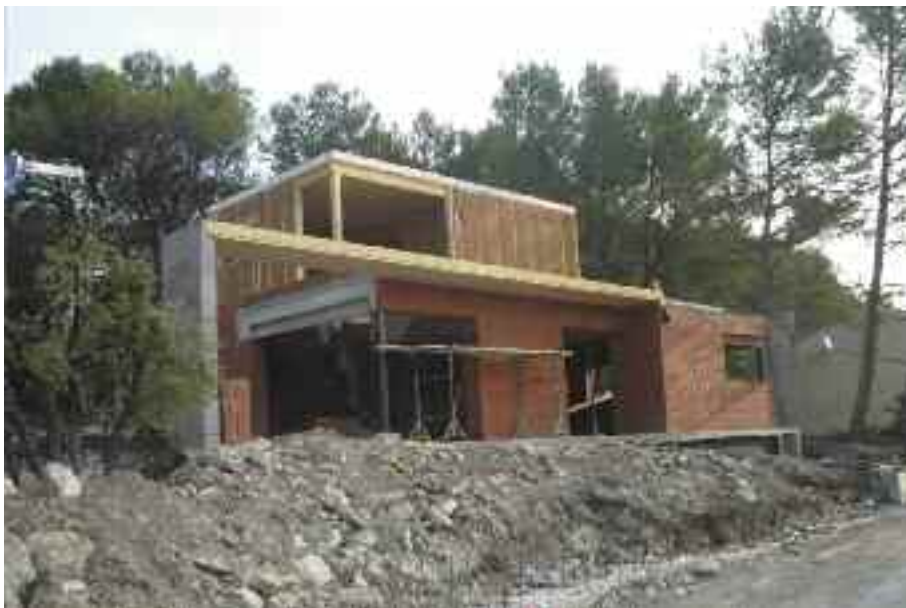
Construction d'une maison contemporaine individuelle à Saint Génès des Mourgues (Hérault) Altitude : 76 m
